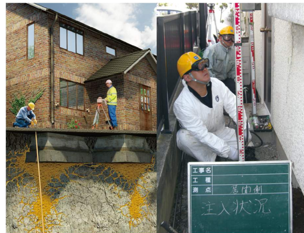
地耐力強化注入状況
