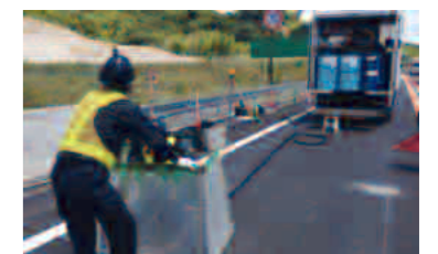
踏掛版施工写真
