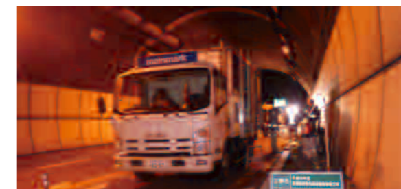
プラント車(3t)設置状況
