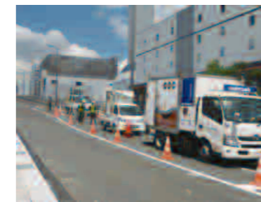
アスファルト舗装道路下の空洞充填
